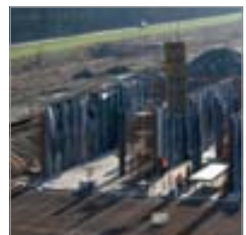
Water Treatment Plant, Essen (D), 2011
